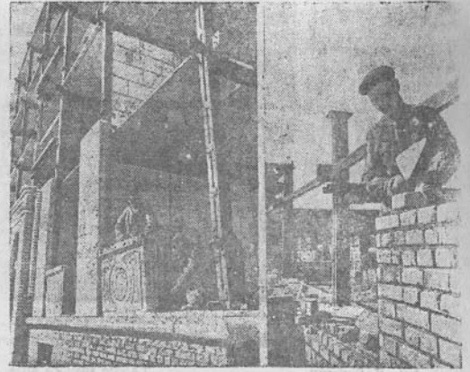
MASKVA. Choroševskio plente išsiplėtė stambiųjų gyvenamųjų namų greita statyba. Statyba vykdoma industriniais metodais — visos detalės gaminamos fabrike, o statybiniams aikštelėje pravedamas tik tal montžas. Nuotraukoje: (iš kairės) — blokų statymas. Iš dešinės — mūrininkas stachanovinis L. S. Kolosnikovas. Foto N. Kirejevo. TASS'o spaudos kišė.
