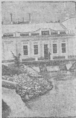
STAVROPOLIO KRAŠTAS. Zellančukako tarpkoloninė hidroelektrinė, turinti 500 kilovoltų pajėgumo, yra pastatyta ant Bolšoj Zellančuk upės.
