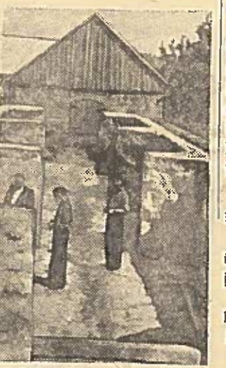
Kalvarijos rajono kolūkiuose statomi silosavimo įrenginiai. Nuotraukoje: naujas siloso įrenginys „Taikos“ kolūkyje. M. Ogajaus (ELTA) nuotrauka.
