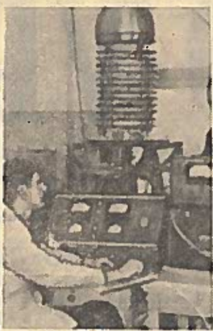
KIJEVAS. Ukrainos TSR Valstybinio plano automatikos institute įrengiamas mažo gabaritų neitronų generatorius. Šis prietaisas sudarys galimybę su dideliu tikslumu kontroliuoti sudėtingų cheminių medžiagų sudėtį gamybiniame sriauje ir bus plačiai taikomas įvairiose pramonės šakose.
